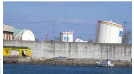
Bacs déplacés par une submersion de 4,3 m dans le dépôt portuaire de Kuji
