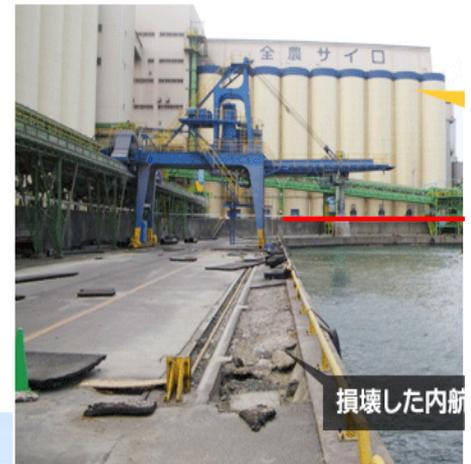
Extérieur et intérieur d'un silo de céréales endommagé par le tsunami et ses débris près de Natori (Source : DGPR), à dr. : liquéfaction du quai du silo à grain du port de Kashima
