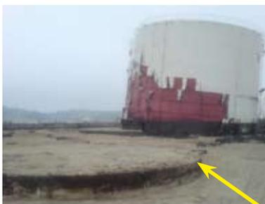
Bac de fioul déplacé de ses fondations par le tsunami (photo amateur)
