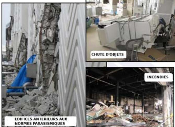
Les 3 principaux types de dommages constructifs, conséquences des secousses sismiques, qui ont été constatés après le 11 mars 2011 au Japon
