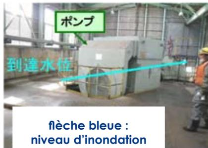
à g. : 1 des 6 moteurs de la station de pompage endommagés par le tsunami, à dr. canalisation d'eau de mer recouverte de sédiments (Source : METI)
