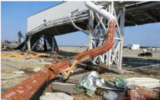
Convoyeur portuaire de charbon endommagé par le tsunami dans la centrale de Sinchi-Soma
