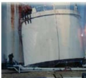
Petit bac vide (3 000 m<sup>3</sup>) arraché de ses fondations par le tsunami (Source : NRFID)
