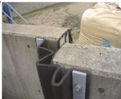
Déformation des murs d'une cuvette de rétention suite à liquéfaction dans le dépôt pétrolier de Kashima
