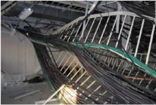
Effondrement des racks de câbles électriques sous plafond
