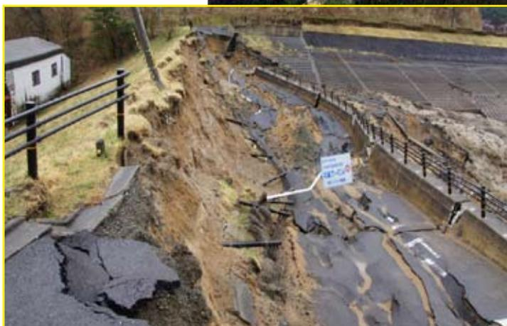
Vue du barrage de col après le glissement, probablement provoqué par la vidange rapide du réservoir (Source : GEER / L.F HARDER)
