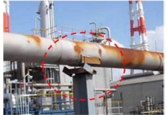
Dommages sismiques subis par les tuyauteries : à g. calorifugeage et à dr. leurs supports (Source : METI)
