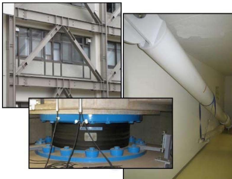
Exemples de dispositifs parasismiques installés dans les bâtiments au Japon
