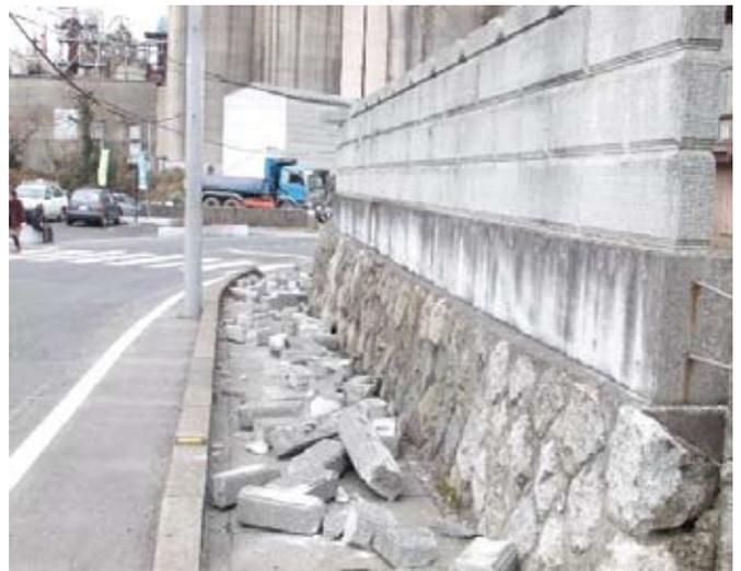
*Cimenterie à Hitachi, mur endommagé par le séisme (photo amateur)*
