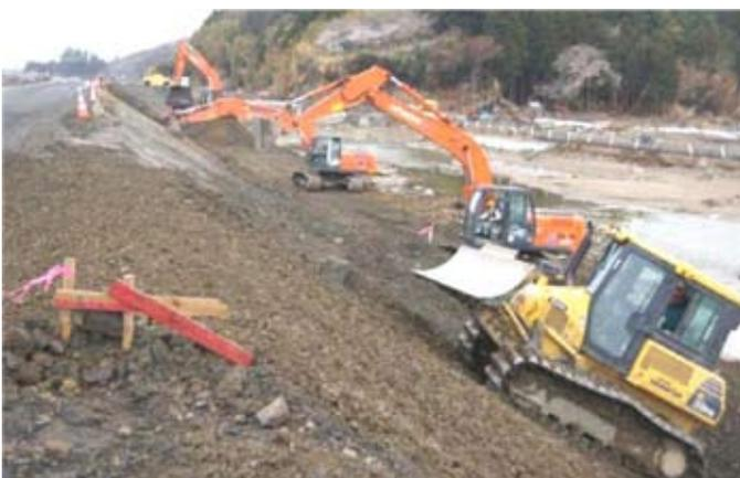
Reconstruction de la digue de la rivière Kitakami en avril 2011 suite aux dommages provoqués par le tsunami. Sur cette rivière, le tsunami a submergé les digues sur 5,5 km de distance depuis son embouchure et a remonté son lit sur plus de 49 km à l'intérieur des terres (Source : GEER)
