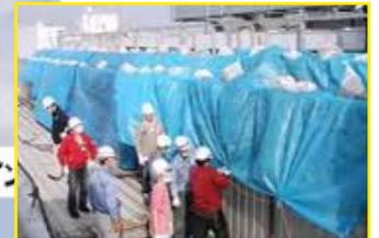
Réparation d'urgence de la toiture de la salle blanche avec des sacs de sables et des bâches pour limiter la contamination par l'air extérieur
