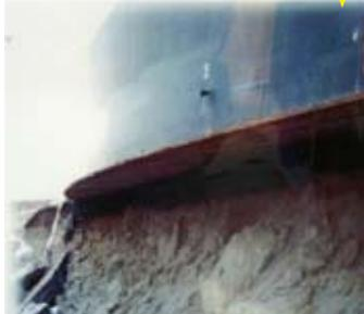
Erosion du sol par le tsunami sous les gros bacs de stockage, atteignant 3 m par endroit (Source : JX)
