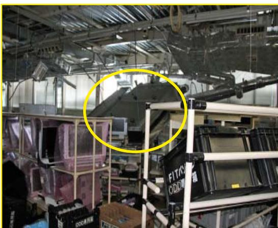
Chute d'un climatiseur sur les racks de stockage des pièces détachées au 2<sup>ème</sup> étage (Source : Fujitsu)
