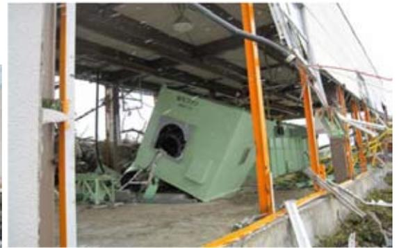
Domages extérieurs : bassins d'aération - tuyauteries - équipements de traitement (Source : Préfecture de Miyagi - JWSA)
