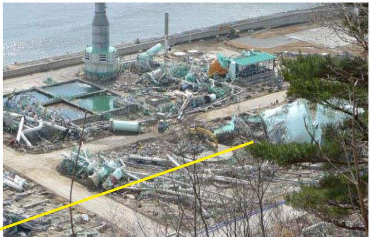
(Haut) Bacs extérieurs de fuel et d'eau emportés par le tsunami et (gauche) état des installations de surface de la réserve nationale stratégique de Kuji, les bacs de carburants stockés en caveau sont intacts mais l'eau de mer à l'intérieur a dû être pompée
