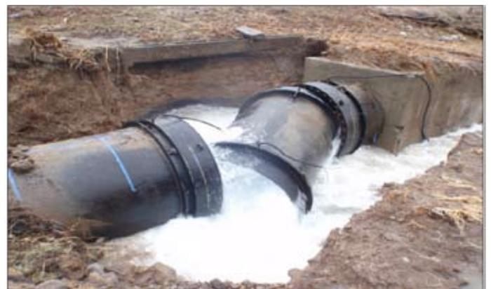
Rupture d'une canalisation d'eau potable de diamètre 2400 mm (96'') malgré la présence d'une bride déformable sur 500 mm (Source : Préfecture de Miyagi)
