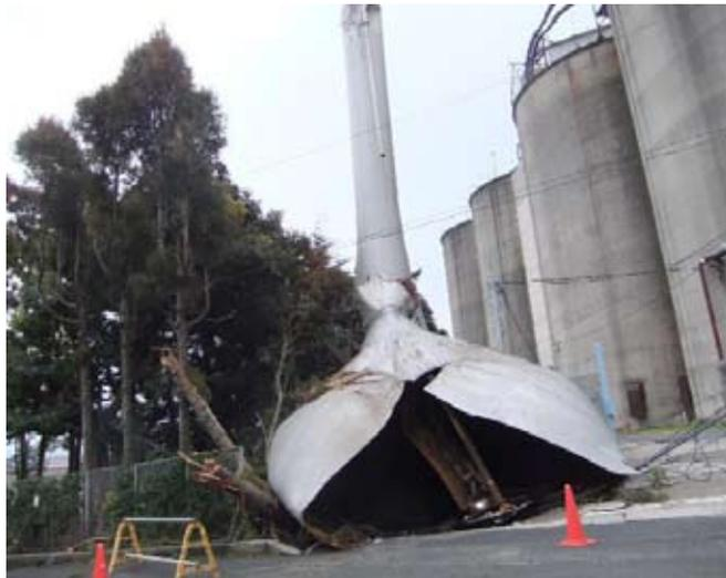
*Cimenterie à Hitachi, bac de stockage d'eau endommagé par le séisme (photo amateur)*
